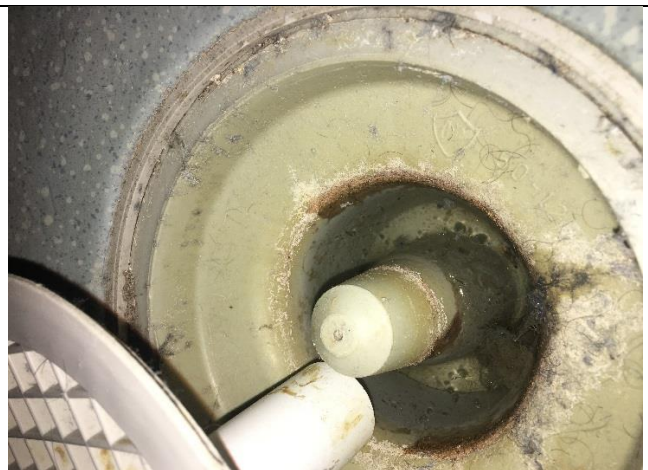
golvbrunn sedan byggåret.
