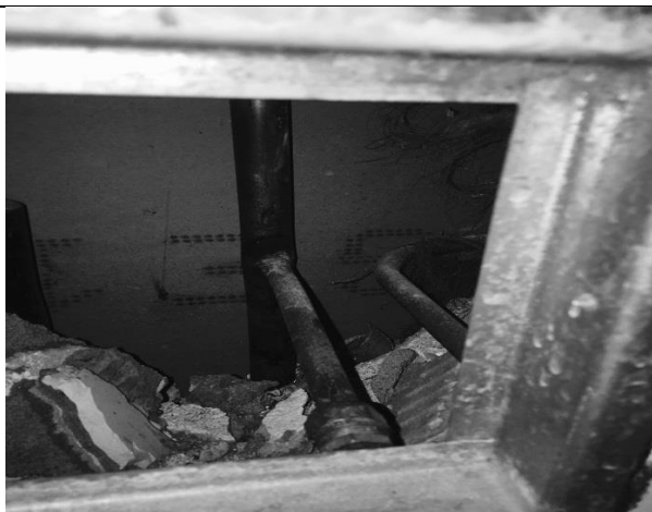
Bristfälliga och otäta slitsbottnar som saknar skvallerrör
