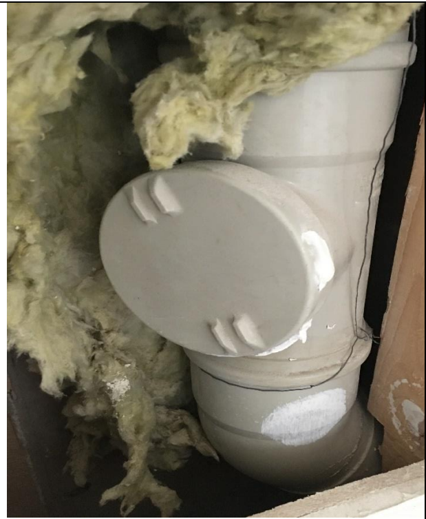
PVC plast blir spröd med tiden.
