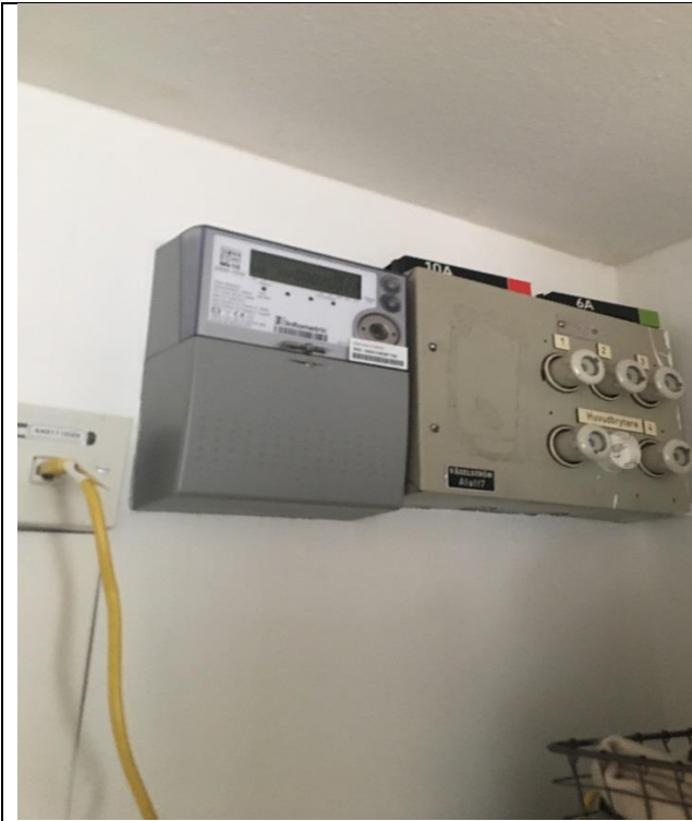
Elcentralerna har gängsäkringar
